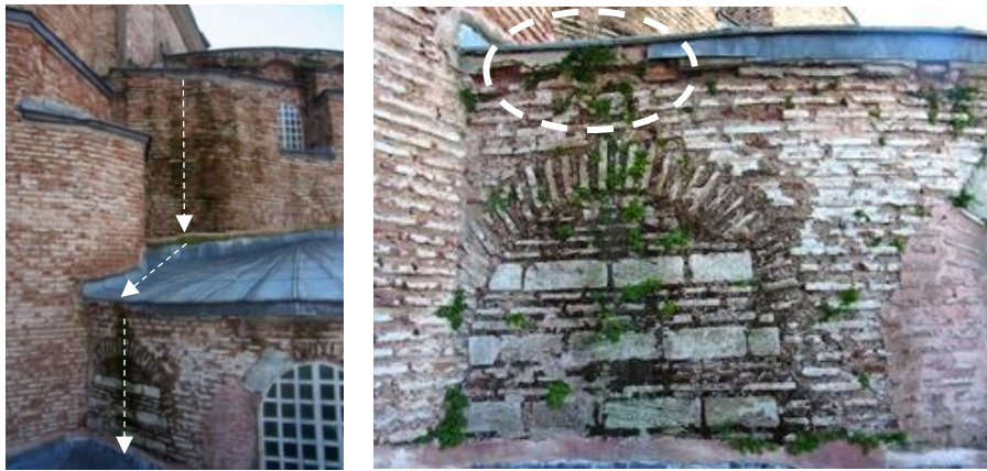
写真 4.22 北西エクセドラ(位置番号 91) 外装除去後：2012年9月
