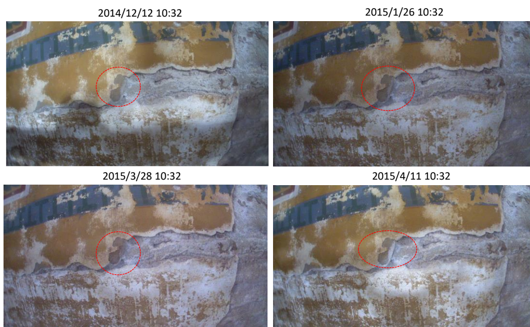
図 3.12 硫酸ナトリウム塩析出箇所における塩の析出と消失
