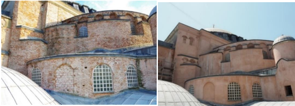
写真 2.7 北西部外壁 左：外装除去時(2012年9月)、右：外装再被覆後(2014年12月)
