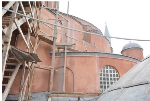
写真 4.25 外装材被覆後の北西エクセドラ(外装再被覆後：2014年12月)
