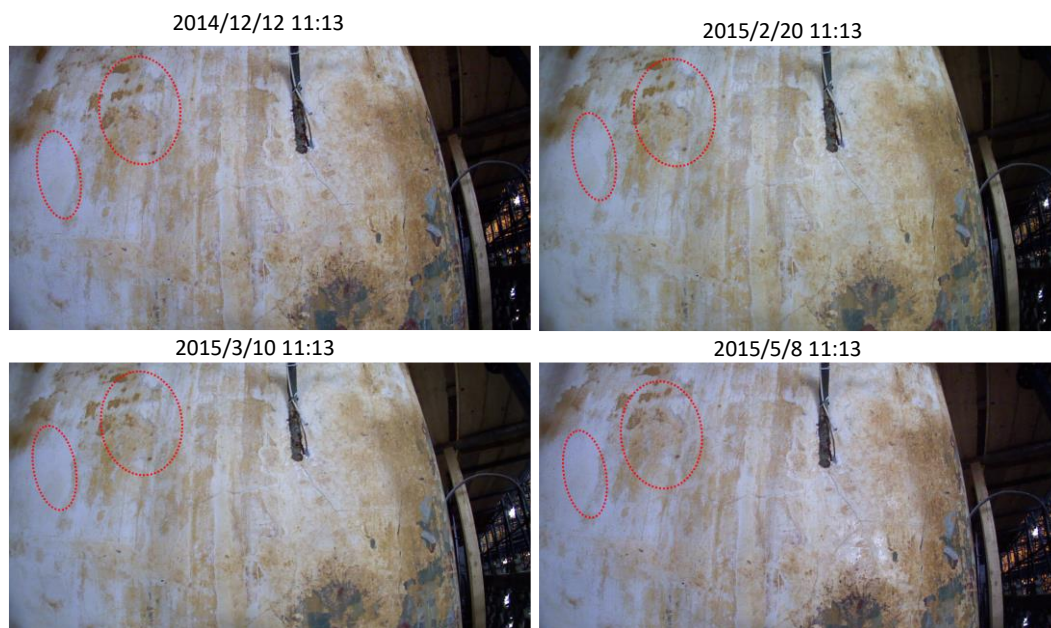
図 3.11 硝酸ナトリウム塩の析出箇所における塩の析出と消失
