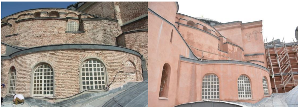
写真 2.8 南西部外壁 左：外装除去時(2012年9月)、右：外装再被覆後(2014年12月)
