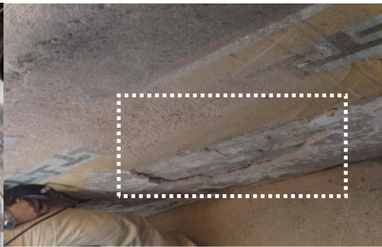
写真 4.16 位置番号 62 の躯体の露出
