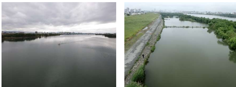
図 1.1.24 淀川大堰湛水区間（左）・城北ワンド（右）
