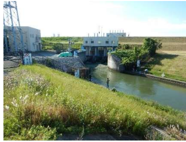
図 1.1.27 神崎川及び猪名川における河川横断工作物（一津屋樋門）
