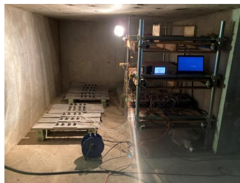
写真 5-6 F10T ボルト計測状況
