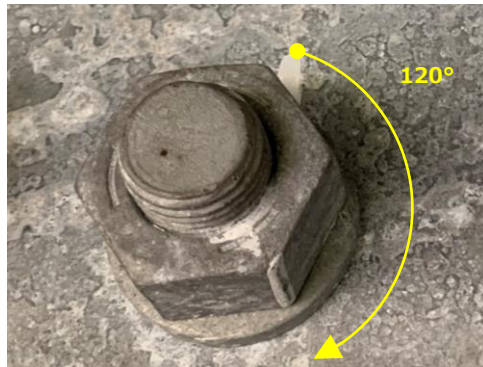
写真 2-18 ナット回転法 120^\circ マーキング確認
