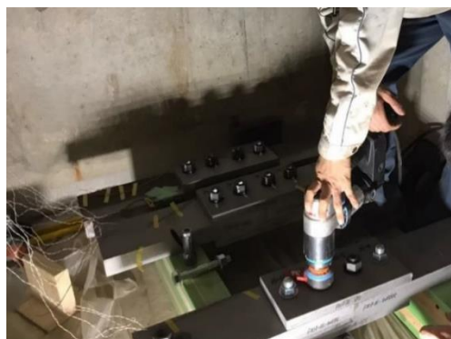
写真 5-5 F10T ボルト締め付け施工時
