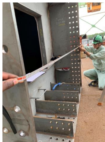
(f) ウェブ間隔の計測状況
