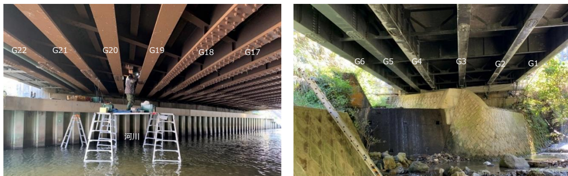
(a) E 橋（耐候性鋼橋梁） (b) F 橋（溶融亜鉛めっき橋梁）
