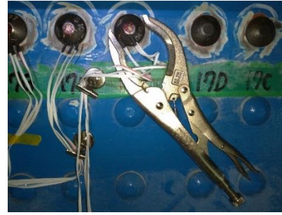
写真 2-8 トルシア形高力ボルトの バイスプライヤーによる固定
