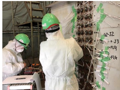
(b) 残存軸力測定作業状況
