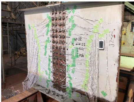
(a) 残存軸力測定準備作業状況
