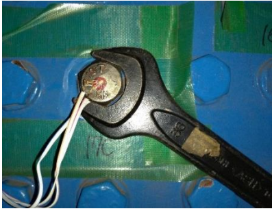
写真 2-7 高力六角ボルト (M22) の M24 (呼び 36) スパナによる固定
