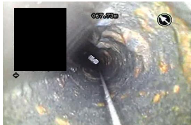
図 2.3 管路腐食被害の例
