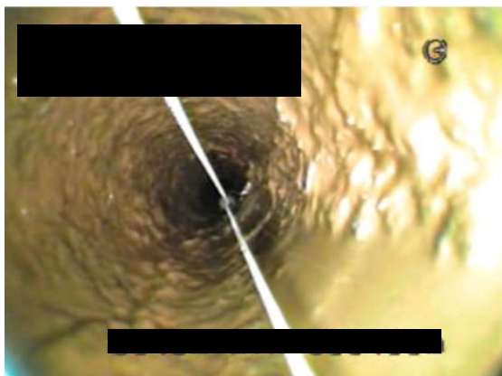
図 2.3 管路腐食被害の例
