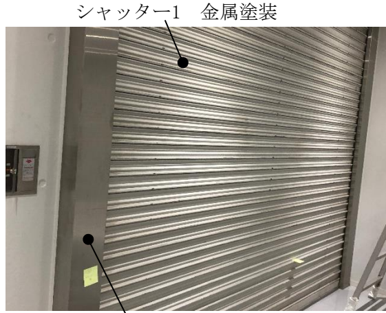
シャッター枠 SUS ヘアライン仕上
