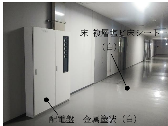
b) 床面、配電盤
