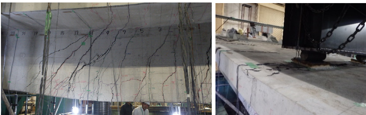
写真-3.11 ケーブル破断側の状況（左）と上フランジ上面の圧壊状況（右）（供試体 G2）
