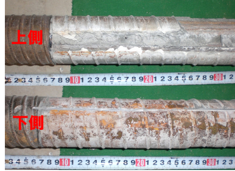
(b) シース内側グラウト外観
