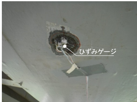
写真-4.6 ひずみゲージ貼り付け状況
