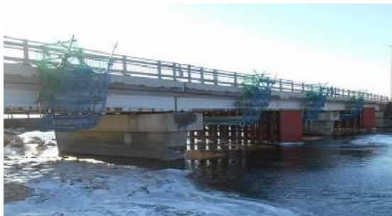
写真-2.8 対象橋梁
