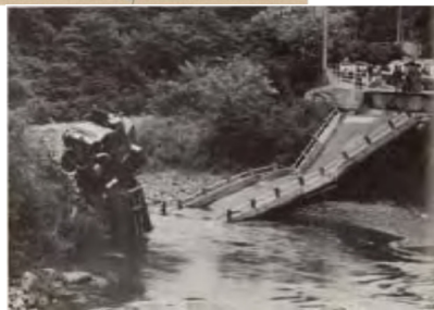
(c) 新管橋 (長野県) 1.10)
