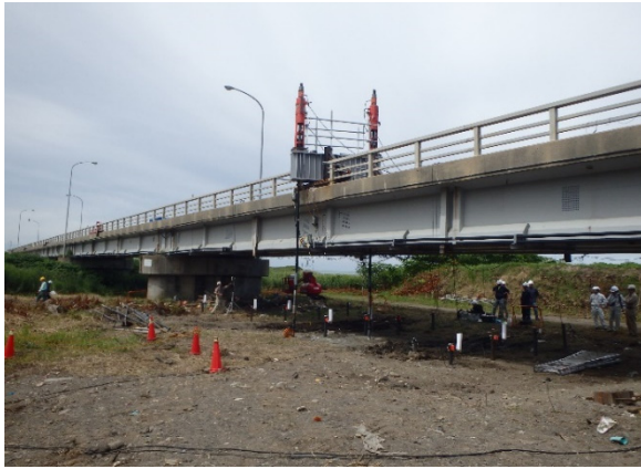
写真-4.8 載荷試験前の全景
