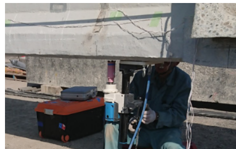
写真-2.11 コア応力解放法の調査状況
