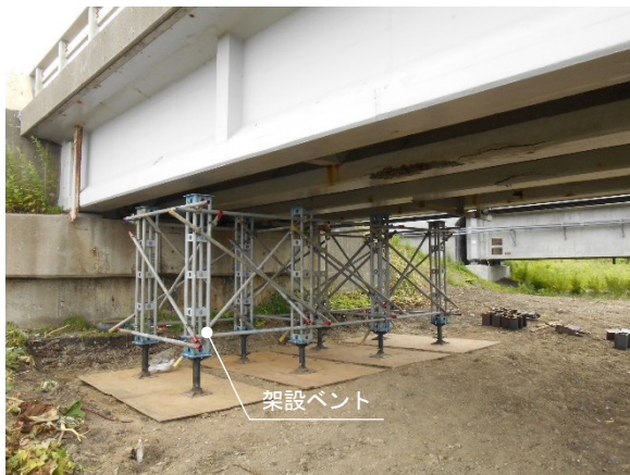
写真-4.13 架設ベントの設置 (A1 橋台)
