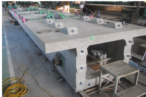
写真-3.1 供試体 G0 の外観
