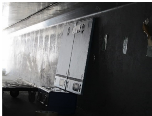
写真-3.5 IPフィルムの設置状況（箱桁内部）
