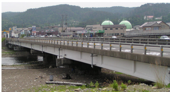
写真-2.3 橋梁全景
