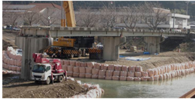
写真-2.2 橋梁全景（撤去時）
