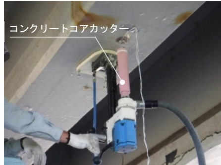
写真-4.7 コア応力解放による計測状況
