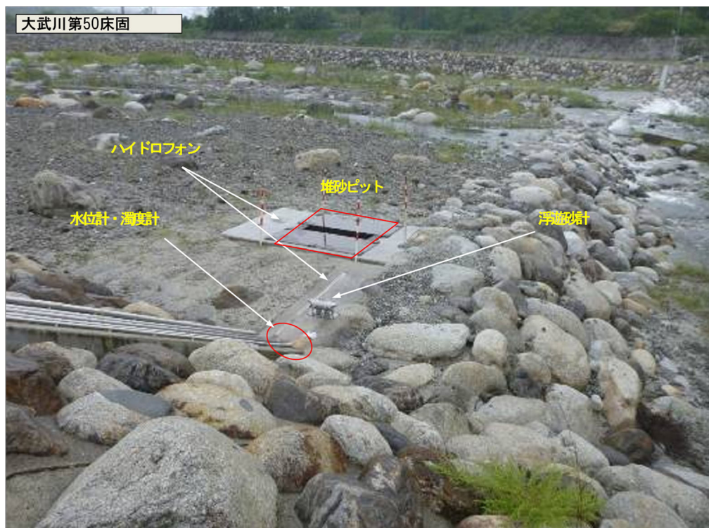
図 4-2 大武川計測器設置状況 1)
