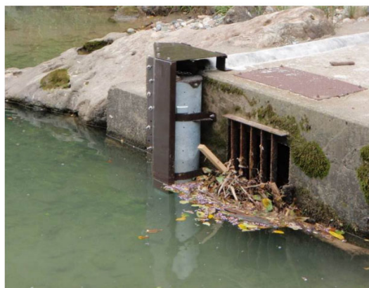
図 2-4 濁度計の設置事例 5)
