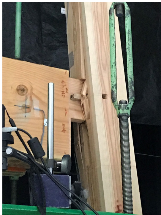
(b) 試験体 K_P 右柱割裂・ほぞ抜け出し
