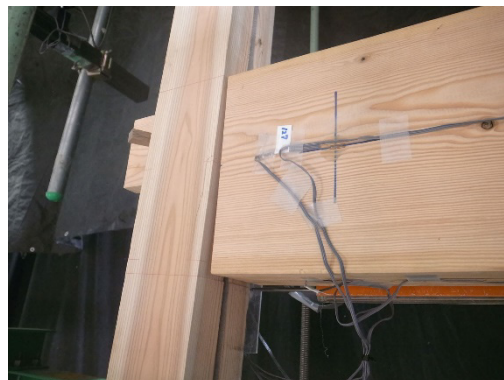
写真 5-1 鼻栓試験体 H 左接合部の負加力時変形状況
