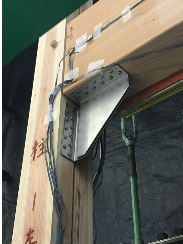
写真 3-2 試験体 K_B 仕口ダンパー設置状況
