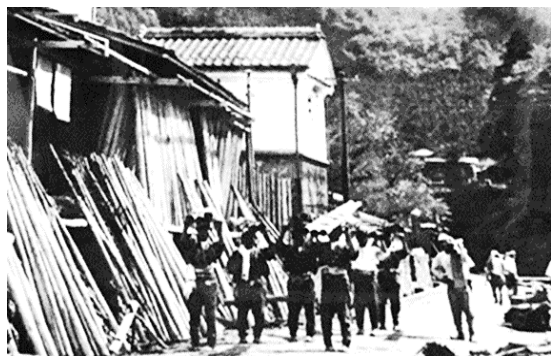
写真—1 明治初期，垂木を頭上に乗せ京都へ搬送する様子
