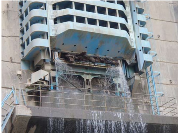
図 1-5 閉塞した裾花ダムのコンジットゲート（文献 9) より引用）
