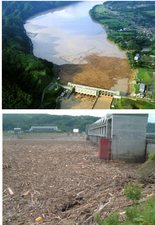
図 2-19 平成 15 年 8 月の二風谷ダムにおける流木発生状況（上：全体，下：堤体近傍） 25)
