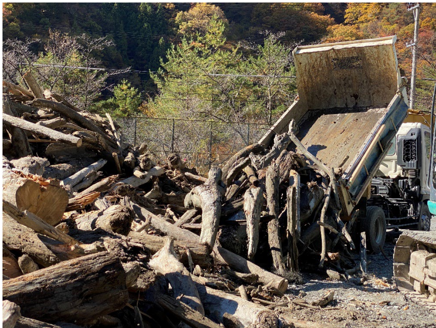
図 3-28 小渋ダムにおける陸揚げ流木回収状況
