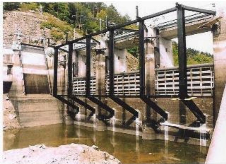
図 2-24 Thurnberg reservoir (オーストリア) の洪水吐き流木対策 (文献 32) より引用)
