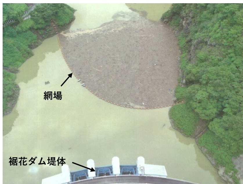
図 3-24 裾花ダム流木捕捉状況(2020年7月)
