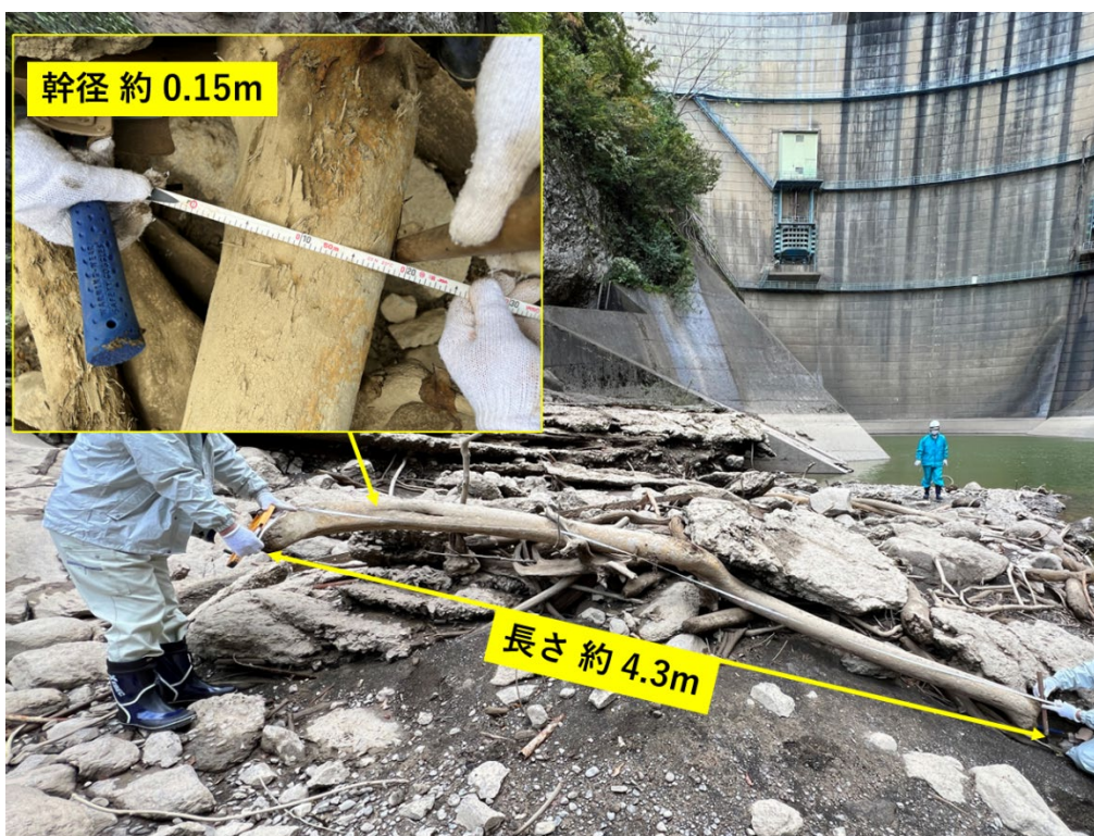
図 2-8 減勢工内沈木調査状況（その 1）
