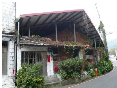
図8 修復が施されている伝統民居（士林区）
