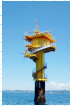
白浜海象観測所・観測塔
