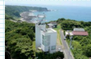
潮岬風力実験所・本館
