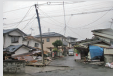
2016年熊本地震による建物被害
