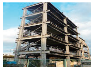
A-3鋼構造実大試験架構
