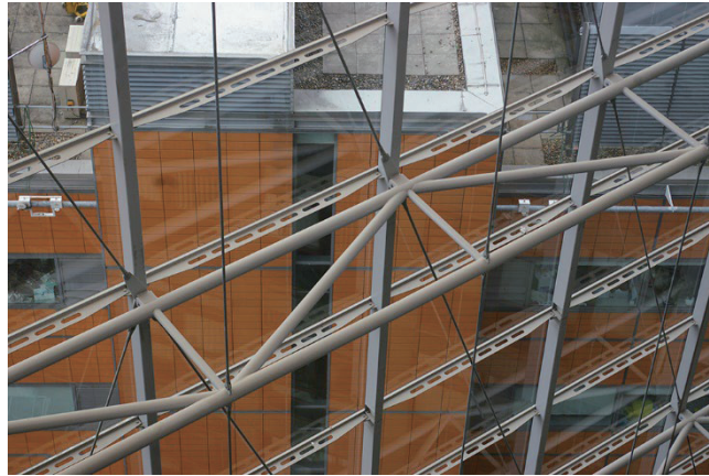
Fig. 5-7 STH Glass Curtain Wall (2015年撮影)
