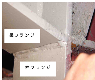
写真 7.2 小学校体育館 10; 柱脚接合部
