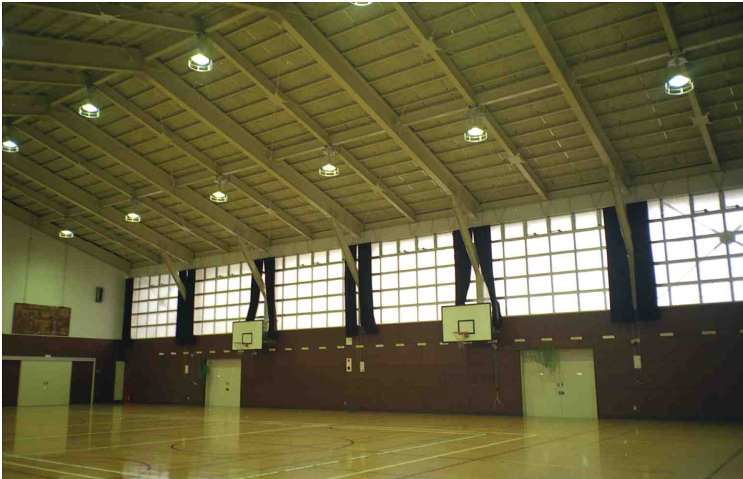
写真 7.4 補強後の内観（中学校体育館）
