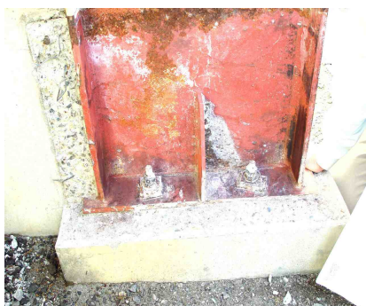
写真 7.1 小学校体育館 10; 柱脚
