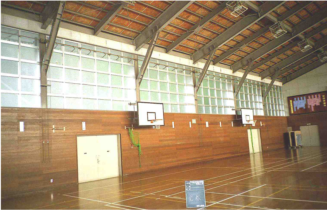
写真 7.3 補強後の内観（小学校体育館）
