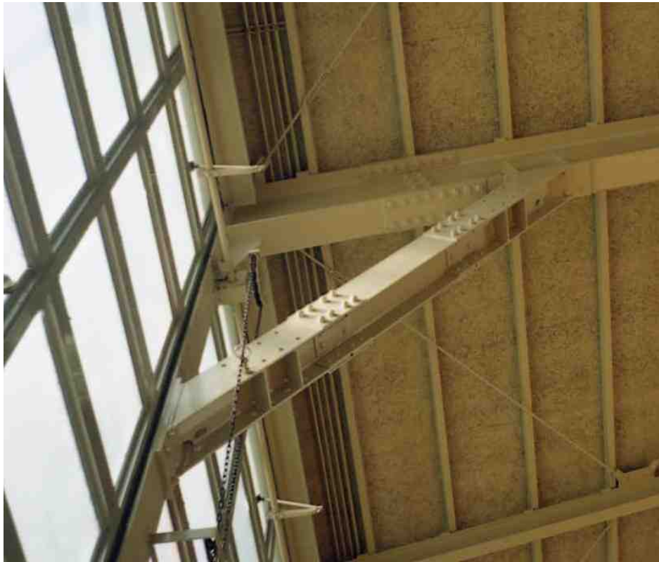
写真 7.5 補強後の接合部
