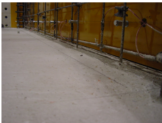
(a) 壁脚部分の目荒らし
