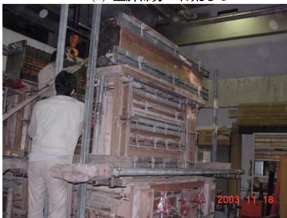
(c) 上部構造打設後
