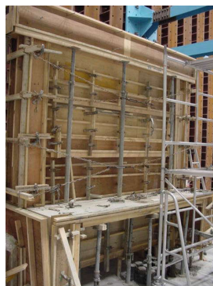
(b) 上部構造打設
