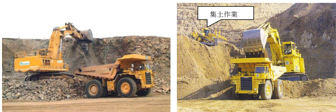
(a) 重機併用ベンチ発破工法の積込み状況
