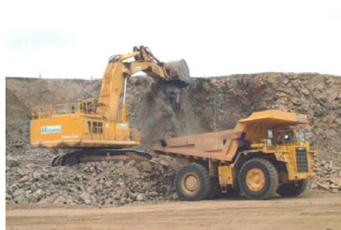
写真 3-5 バックホウ積込み作業
