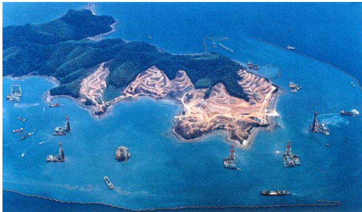
写真 2-1 橘湾火力発電所造成工事
