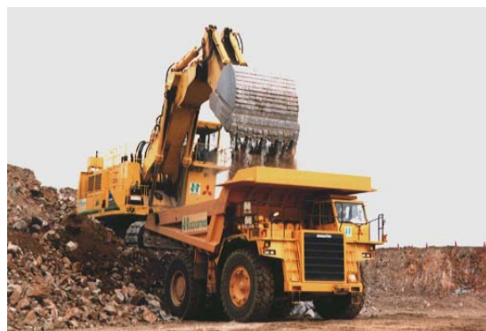
写真3-22 補強バケットによる積込み作業状況
