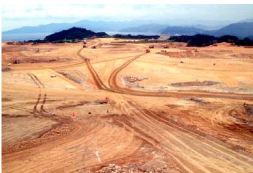
写真 3-4 採掘ヤード(北部より投入口方向)
