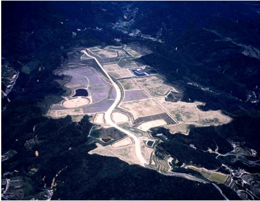
写真 6-1 造成が完了した適用工事（2005 年空撮，南側より津名サイトを望む）
