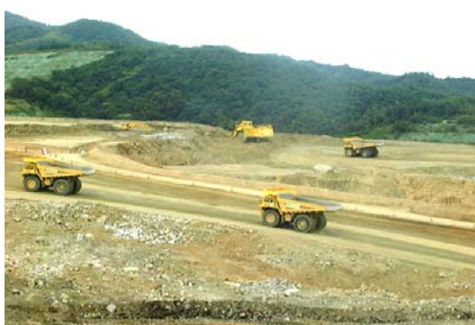
写真 3-6 ダンプ運搬作業
