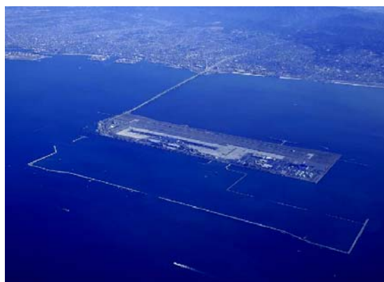
写真 3-1 関空 2 期空港島造成工事
