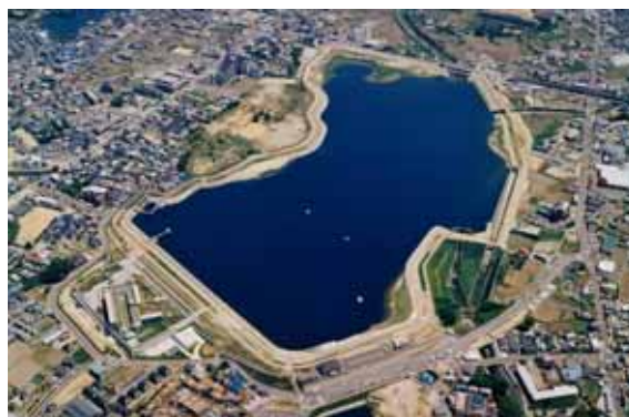
図4-1-1(5) 狭山池ダム写真
