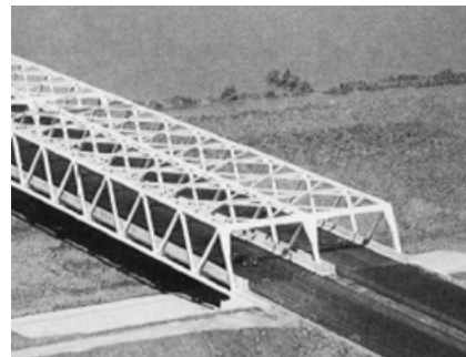
f) 上・下横構 （利根川橋 6) ）
