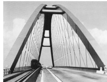
h) バケットハンドル式アーチリブ （利根川橋 8) ）
