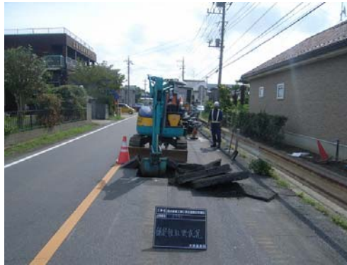
写真 7.4 打換え（舗装版撤去工）
