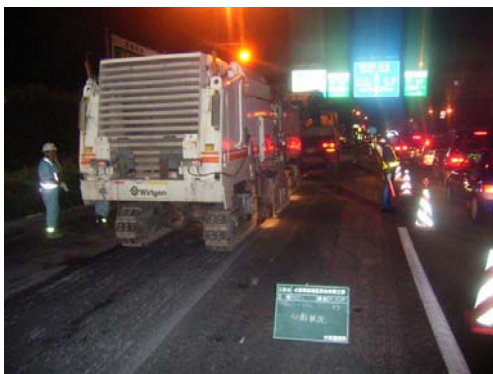
写真 7.2 切削オーバーレイ（切削工）
