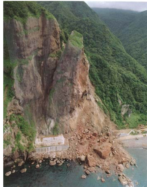
写真-1.2 白糸トンネルの岩盤崩落 12)
