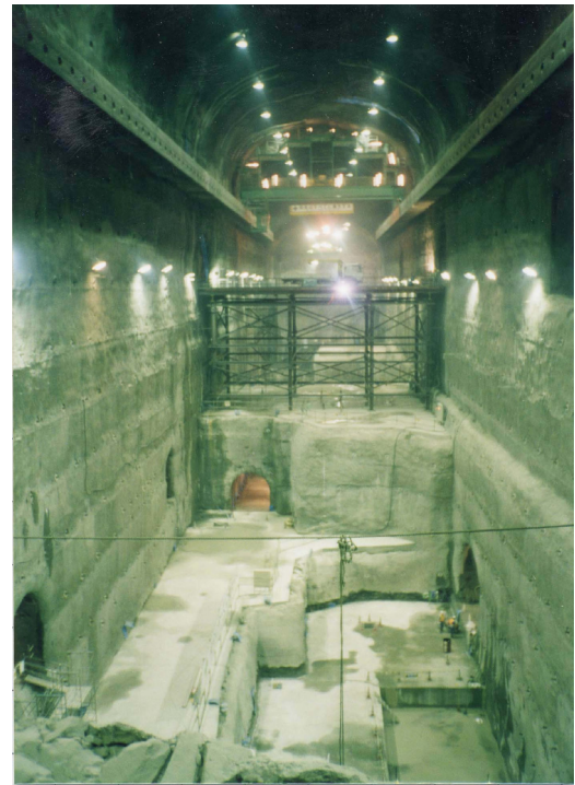
写真-4.2 発電所掘削完了時の状況
