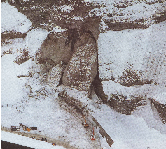
写真-1.1 豊浜トンネルの岩盤崩落 11)
