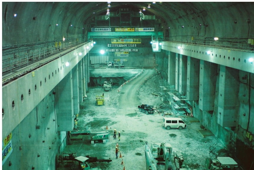
写真-4.1 6 リフト掘削時の施工状況
