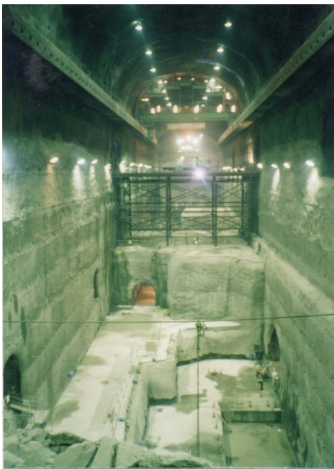
写真-1.3 小丸川地下発電所空洞 W=24.0m, H=48.1m, L=188.0m
