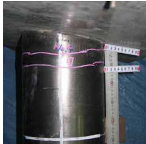
(b) 実験終了時の端部列杭の杭頭の状況
