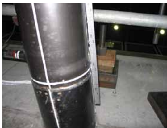
(c) 4 d_f 時の端部列杭の下側結合部付近の状況
