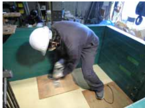
(f) バイブレータで押し固める
