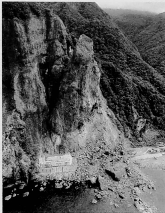
図 1-1 第二白糸トンネル岩盤崩壊 1)
