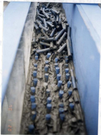
写真-3.5 扇状地上流水路内での土石流及び流木の流下状況
