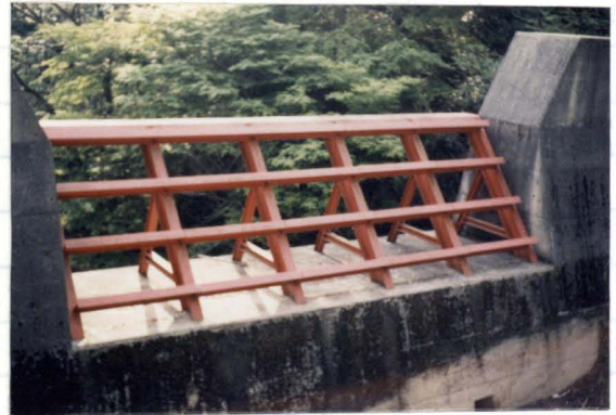
写真-5.1 流木止めの例（六甲山系、宇治川、諏訪山第2堰堤） （スクリーンの全高3m、全幅10m）
