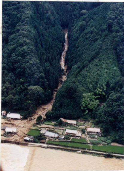
写真-1.11 土石流の発生に伴う立木の滑落（広島県加計町、太田川右支川上原谷川、昭和63年7月）
