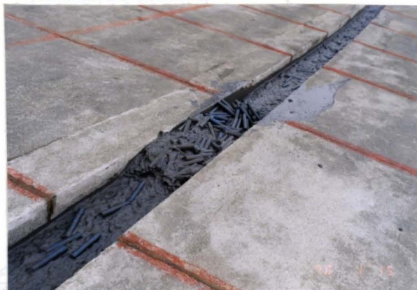
写真-3.9 扇状地内水路に設置された流木止めによる土石流先頭部の流木の捕捉
