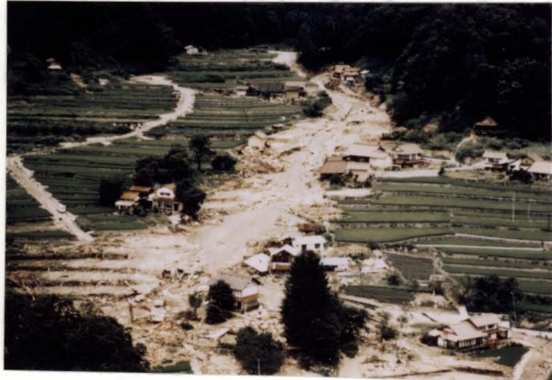
写真-2.1 江河内谷上流氾濫域における土石流の氾濫と家屋の被災状況
