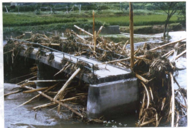
写真-1.3 流木の閉塞による上流での水位上昇により流出した西奥橋（京都府笠置町、木津川左支川白砂川、昭和61年7月）
