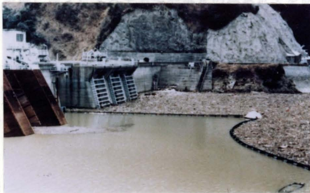
写真-1.4 ダム洪水吐き付近における流木の集積状況（岐阜県、揖斐川、横山ダム、昭和51年）
