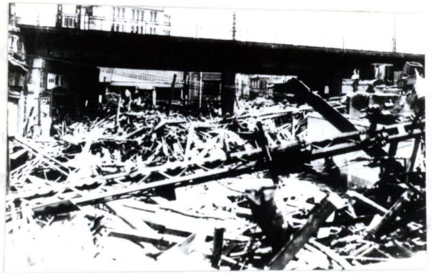
写真-1.8 昭和13年阪神災害時の宇治川下流における流木の氾濫・堆積
