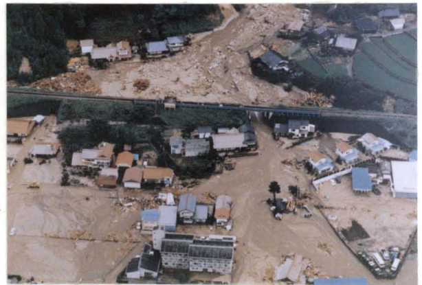
写真-2.2 江河内谷下流氾濫域における土石流の氾濫と家屋の被災状況
