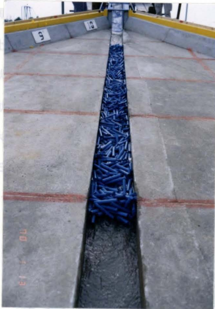
写真-3.4 扇状地水路内に設置された流木止め（高さ3.3cm）による流木捕捉状況
