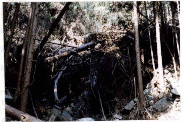
写真-3.24 下流側から見た流木ダム (長崎災害、芒塚2の沢)
