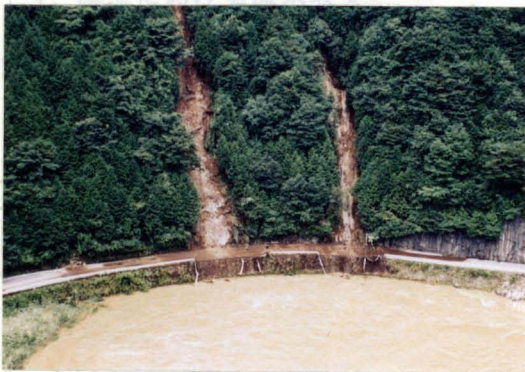
写真-1.10 斜面崩壊の発生に伴う立木の滑落（広島県加計町、太田川左支川、昭和63年7月）
