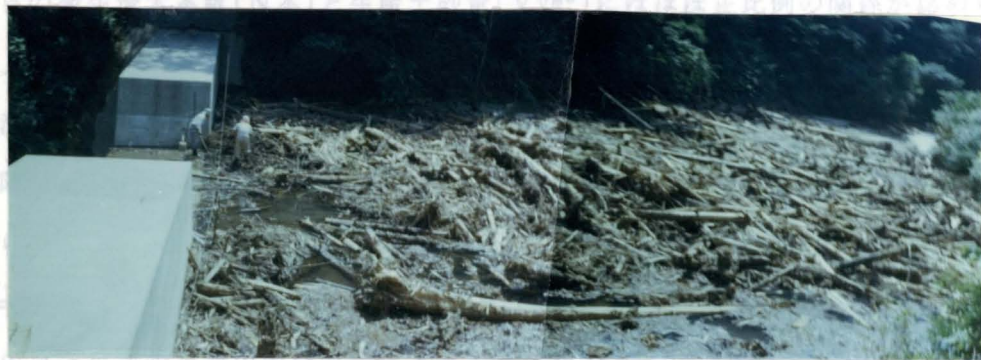
写真-1.14 砂防ダムによる流木捕捉例(昭和63年広島災害、江河内東谷)
