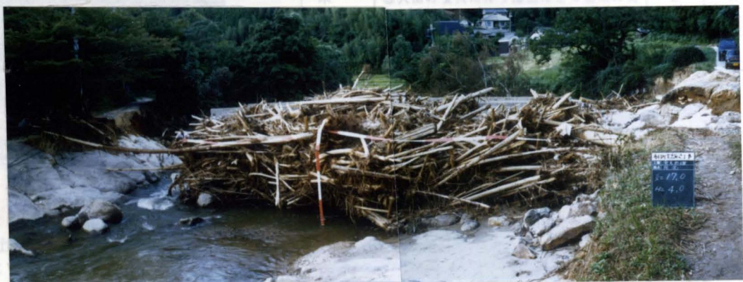
写真-1.9 流木による閉塞による橋梁の破壊 （布目橋、京都府笠置町、木津川左支川布目川、昭和61年7月）
