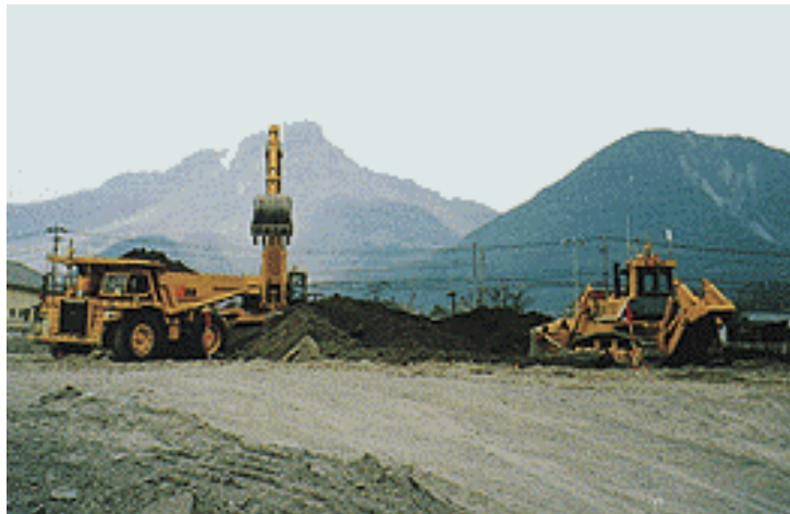
図4.39 遠隔運転中の建設機械
