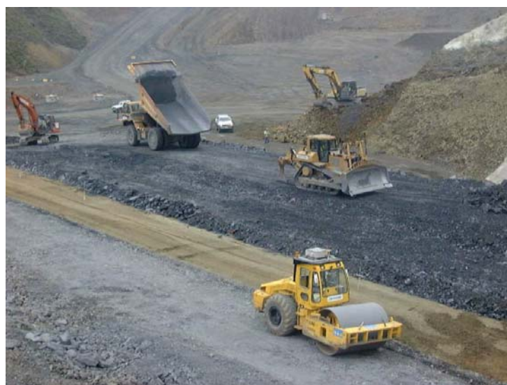
図 4.4 現場施工状況
