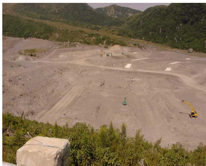
図 4.38 無人化施工現場
