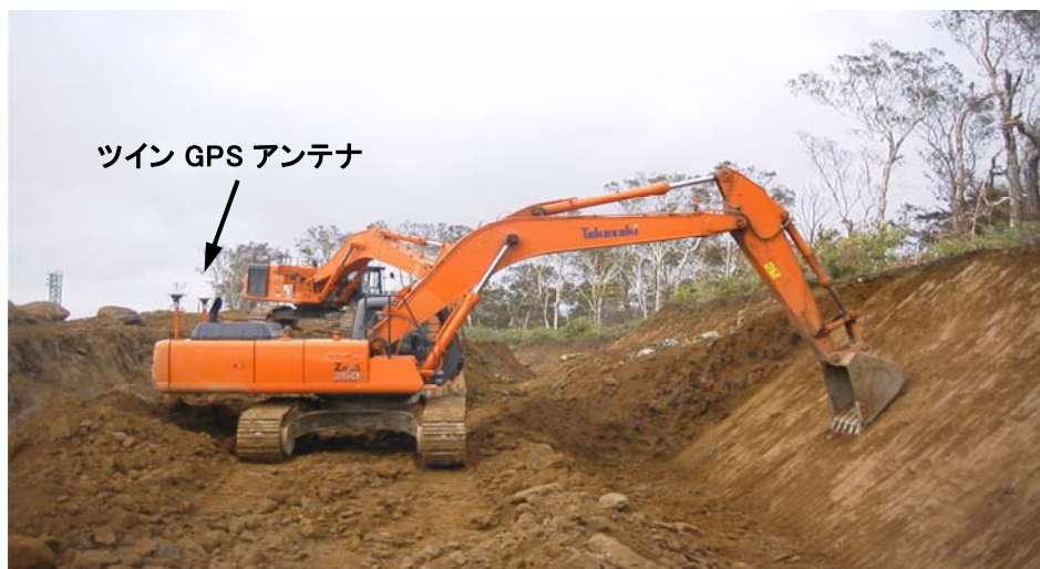
図 4.21 3次元施工油圧ショベル施工状況 (丁張りなしでの法切り作業)
