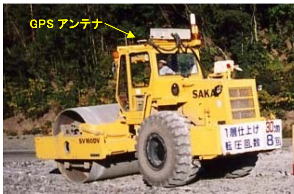
図 5.29 実験時締固め作業状況
