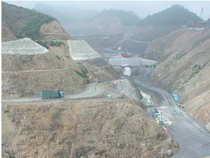
図 4.2 現場施工状況(小丸川発電所工事)
