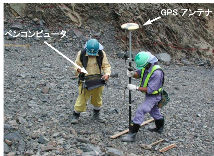
図 4.11 3D-Navi による杭誘導(丁張り)作業
