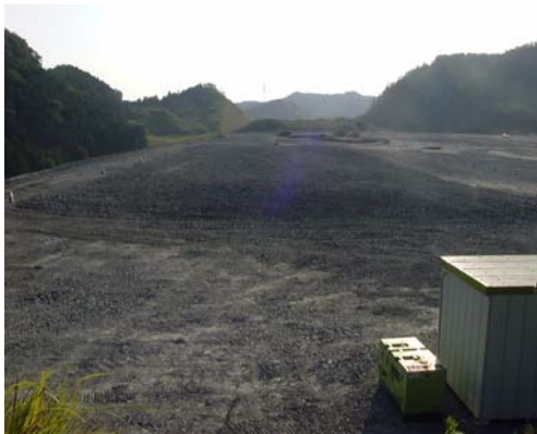
図 5.19 敷き均し終了
