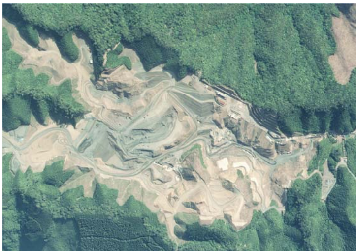
図 4.1 施工中の現場航空写真(小丸川発電所工事)
