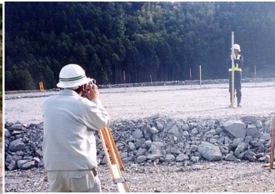
図 5.30 光学式レベル計での測量状況
