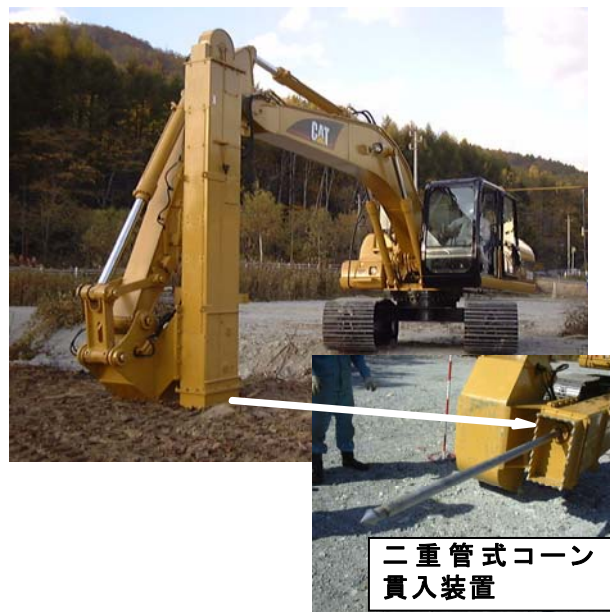
図 4.26 コーン貫入試験状況
