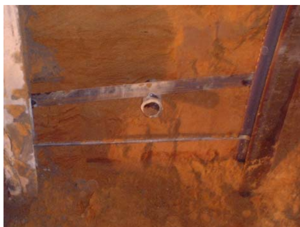
写真-3.2 サイドパイルの施工状況の例
