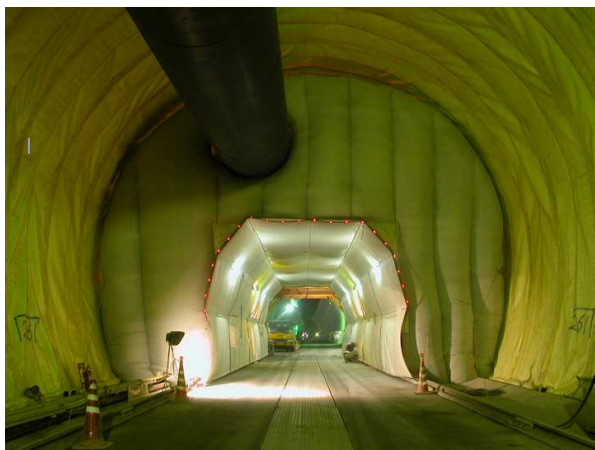
図-7.5 バルーンを用いた養生方法 5)
