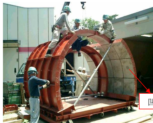
写真-4.2 型枠組立状況
