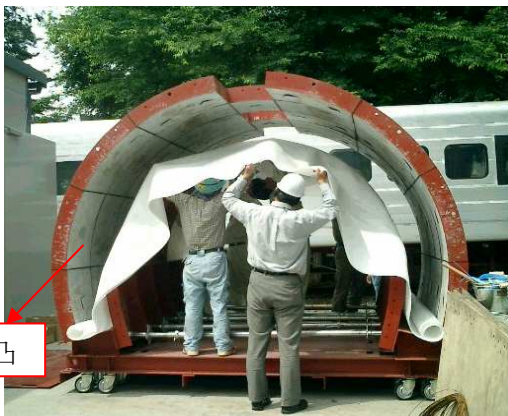
写真-4.3 防水シート設置状況
