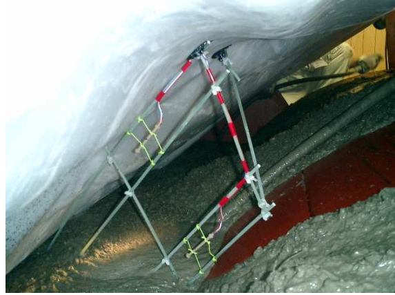
写真-4.6 コンクリート充填状況
