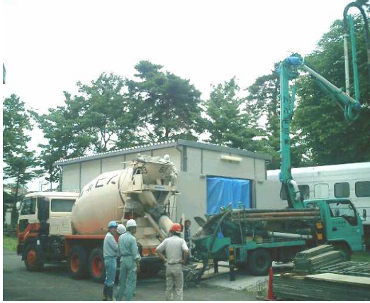
写真-4.5 コンクリート打設状況
