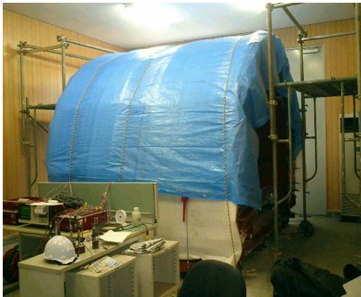
写真-4.7 背面養生状況
