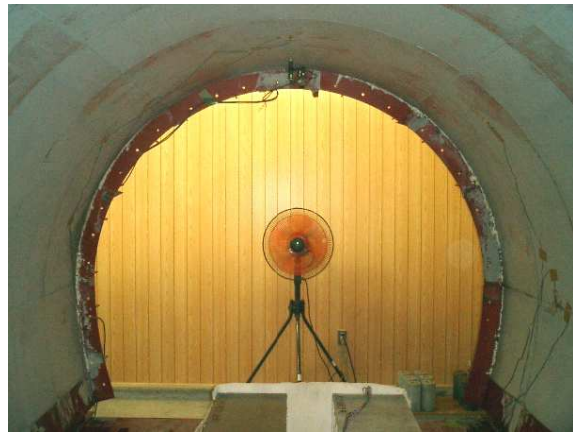
写真-4.8 脱型状況
