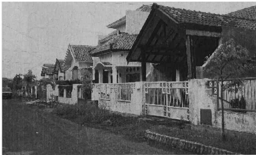
写真 3-4 戸建住宅（タイプB）の外観
