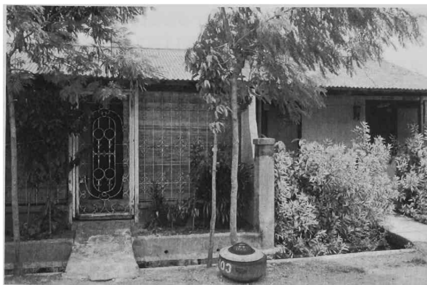
写真 3-1 戸建住宅（タイプA）正面からの写真
