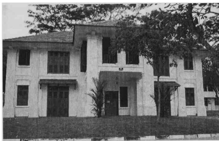
写真 4-2 建物（宿泊施設）正面
