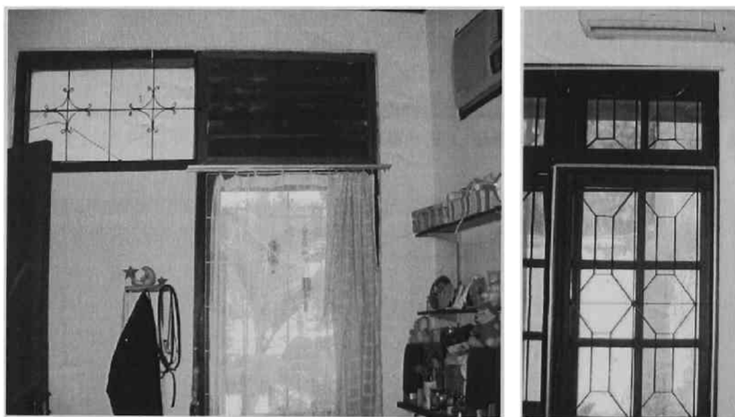
写真 3-11 ガラスによって小窓を閉鎖している様子
