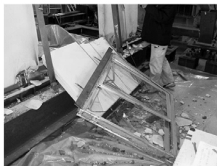
写真 4.3 開口付試験体の損傷
