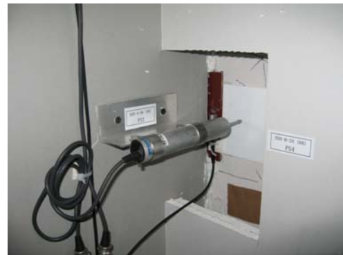
写真 5.2 間仕切り壁の端部 クリアランス計測状況
