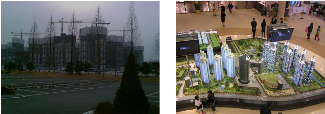
図4-1 K物件の施工現場とモデルハウスの内部
