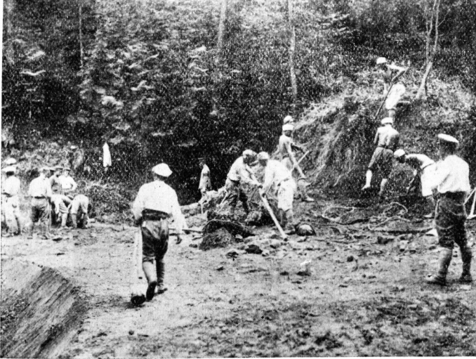
花山道路作業中の伏見工兵隊
