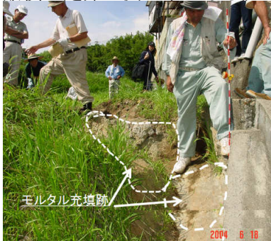
写真-1 モルタル充填跡
