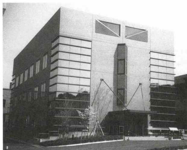
写真-1 VBL棟の外観
