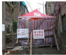
《工事中の通学路》
