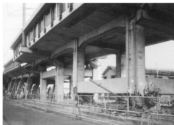
(b) 阪水高架橋
