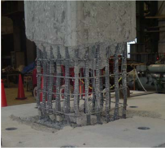
(a) 損傷部除去
