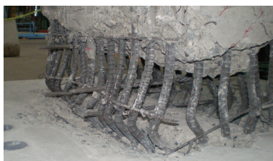
(a) 载荷面ジャッキ側
