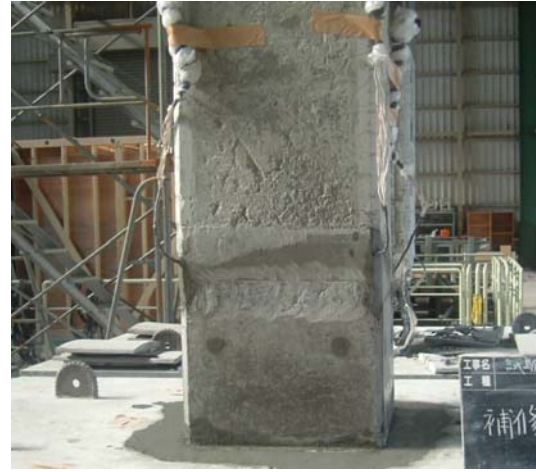
(b) 補修完了
