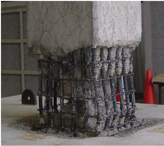
(a) 損傷部除去
