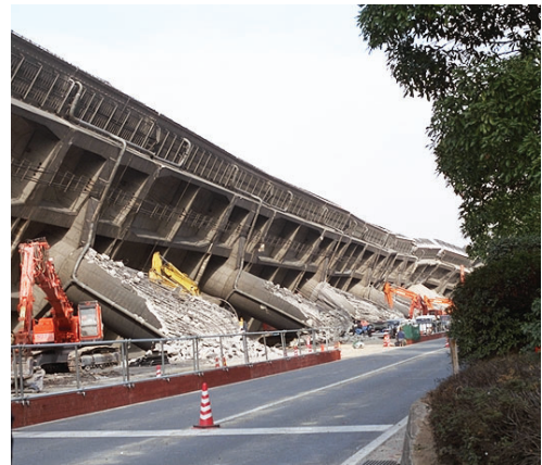
図-6.2.3 阪神高速道路の倒壊
