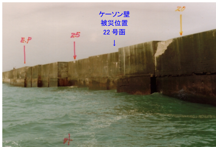
写真 A-18 ケーソンの滑動状況(1982年被災)
