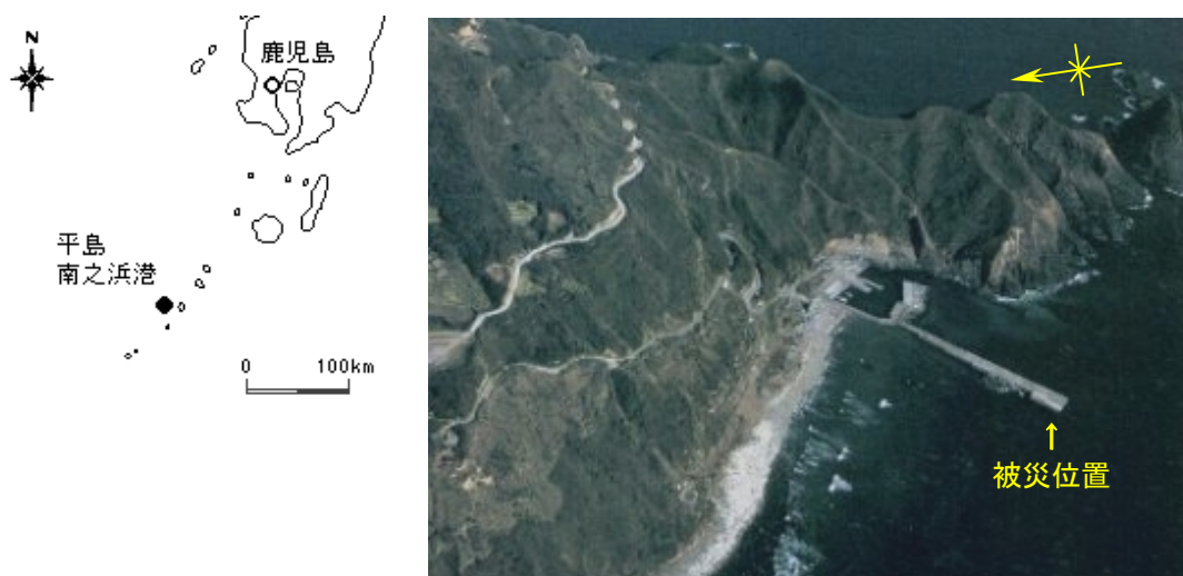
写真 A-10 南之浜港全景
