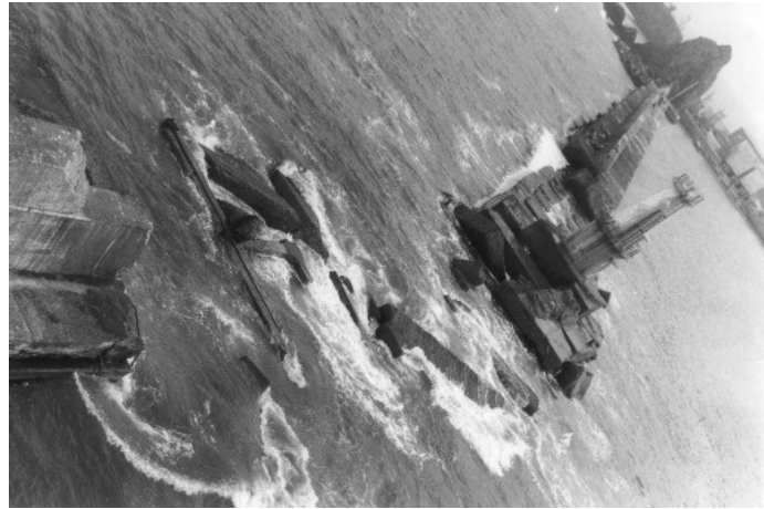
写真-2.4 ケーソン断面と被災状況図
