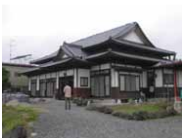
写真1 平屋建物の一例
