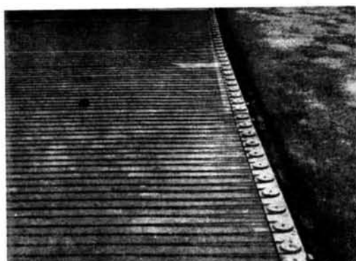
a. 治具による現場ユニット布設
