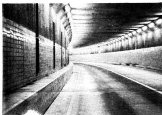
図4-6 比較的良好な区間
