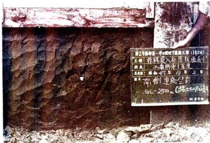
写真 3-4 泥水モルタル遮水壁の仕上り状況
