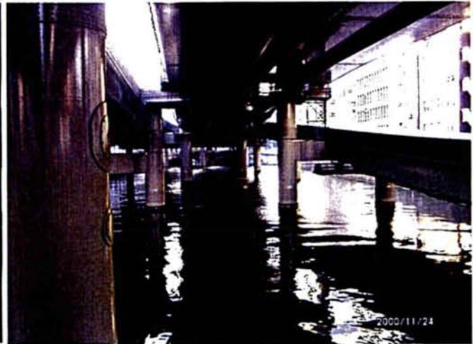
写真 6.2 日本橋付近の景観
