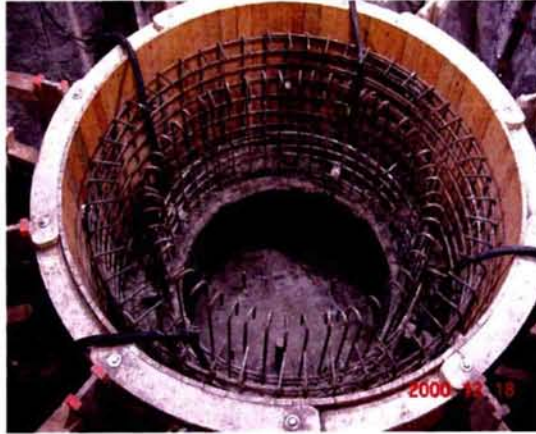
Figure 5.14 コンクリートサイロ施工状況
