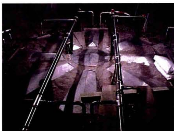
Figure 5.22 計測ケーブル用ステンレス管
