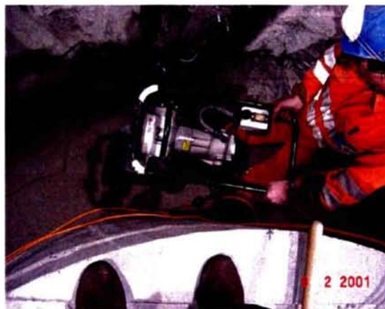
Figure 5.17 充てん材締め固め状況（側壁）
