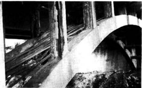
写真6-8-2 市原橋鉄骨架設状況 写真6-8-3 市原橋アーチリブ及び支柱の現況 (メラン式鉄骨鉄筋コンクリートアーチ橋) 5) (平成10年9月筆者撮影) 2)
