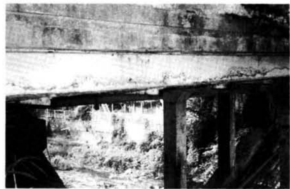
写真6-8-5 市原橋側径間、 鉄筋橋の鉄桁と地覆の意匠線 (平成10年筆者撮影) 2)
