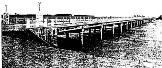
写真 8-3 滋賀県野洲橋、竣工全景。 22)
