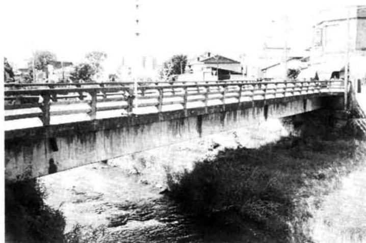
写真 6-41 松本市清水橋現況 (平成12年11月筆者撮影)
