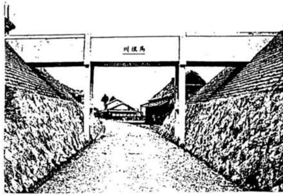
写真5-27 京都府田辺町馬坂川樋橋 (鉄筋コンクリート2層橋脚) 34)
