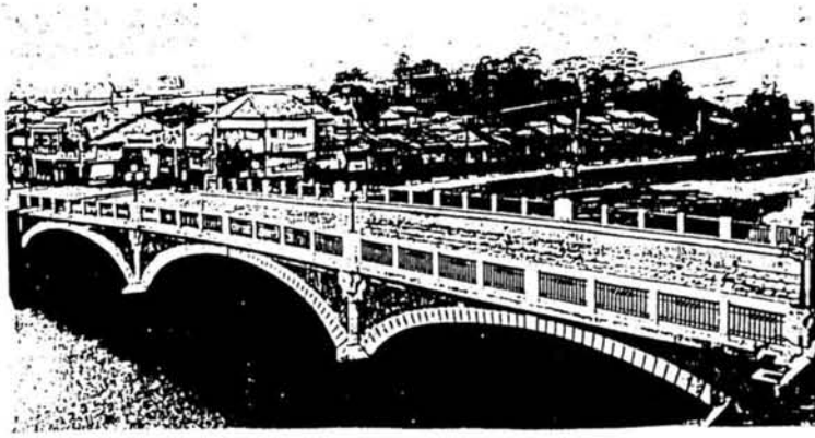
写真 8-7 金沢市浅野川橋、竣工後 23)
