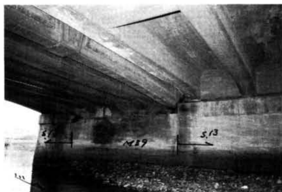
写真6-17-2 佐世保橋、橋脚及び主桁 （左側明治39年石造、右側昭和13年 RC拡幅）（長崎県提供） 20)
