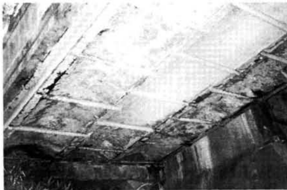
写真6-8-4 市原橋側径間、鉄筋橋下面状況 (平成10年筆者撮影) 2)
