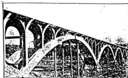
写真4-20 米国加州サン・リュイレイ (San Luis Rey) 河橋 53) 径間5×21.3m 3ヒンジ・プリキャスト鉄筋混凝土アーチ橋 (組立式、橋面のみ現場打)
