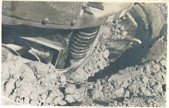
その1 コンパクタが前進し得ないで次第に沈下する状況
