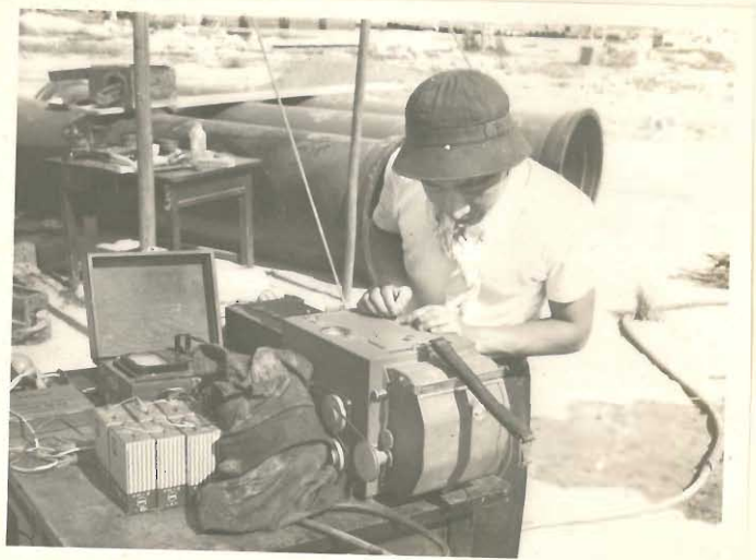
その5. 土圧および加速度測定用記録装置
