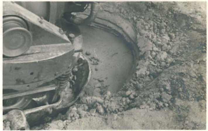
その1 コンパクタが前進し得ないで次第に沈下する状況
