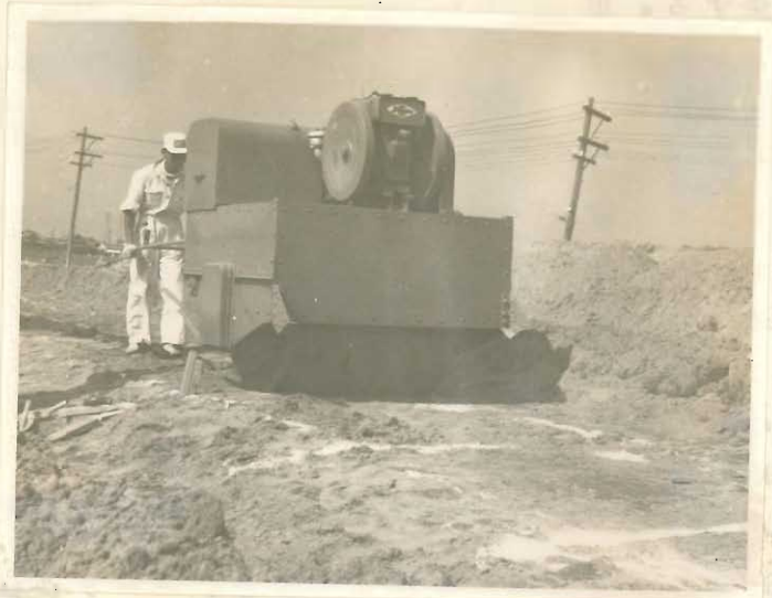
その2. 振動式ローラによる転圧
