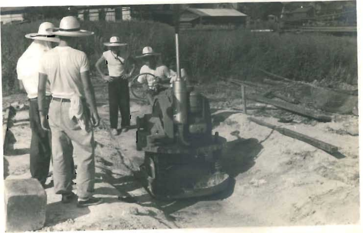
その2. 転圧中のコンパクタ
