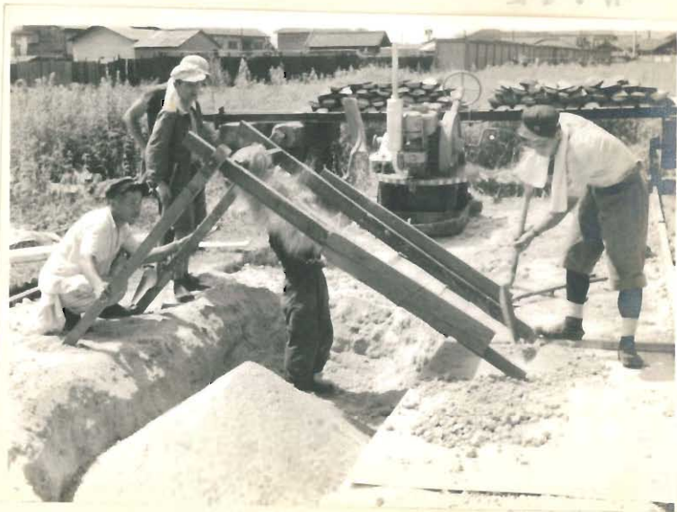
その1. 試料の含水比変更とフルイ分け作業
