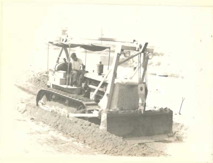
その1. ブルドーザによる試験盛土のまき出し
