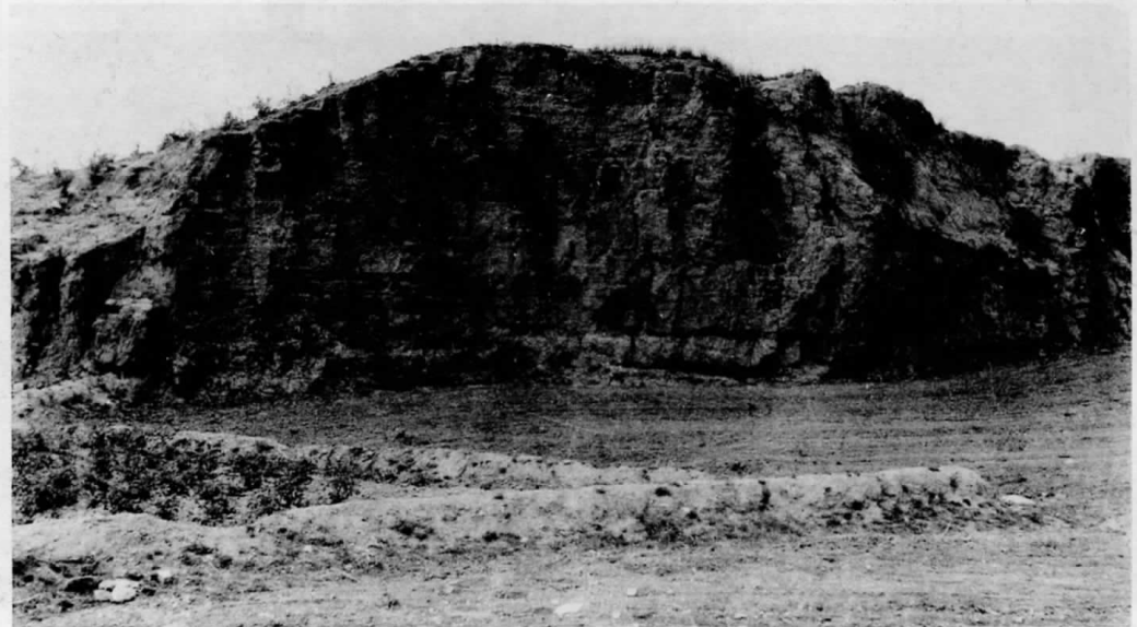
第十六圖 大同古城北壁版築(斷面) Fig. 16. North Wall of Pounded Earth (Section).
