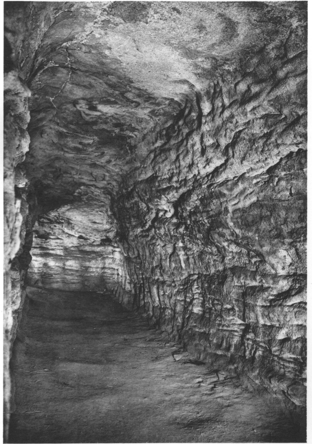
B) Passage, General View (from East). 隧道 全景 (東より)
