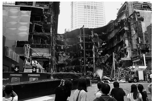
写真4 炎上したデパートの一部 (2010年5月23日撮影)
