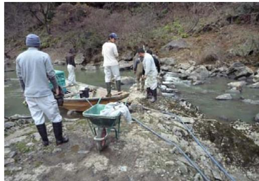
写真：保津峡における、「水寄せ」と呼ばれる石組みを修復する「本川作」のようす。この石組みは、江戸時代初期の保津川開削時から何度も修復されながら現在も使われている。（写真提供：石田亮太氏）
