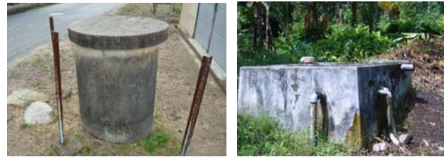
写真2: 野州市、篠原区の湧水の水源地と分岐水槽の構造（左）。パンチュランの分岐水槽（右）。
