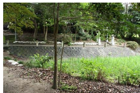
写真2:蛸江神社付近の野洲川旧南流の石垣の堤防。
