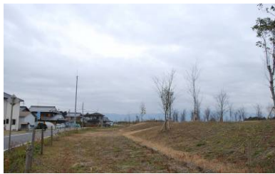
旧野洲川南流の堤防。掘削されて、家屋より低くなった。
